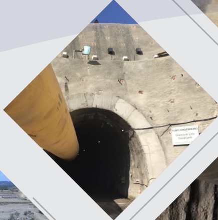
Túnel Eng. Giancarlo Lins Cavalcanti - Emboque
