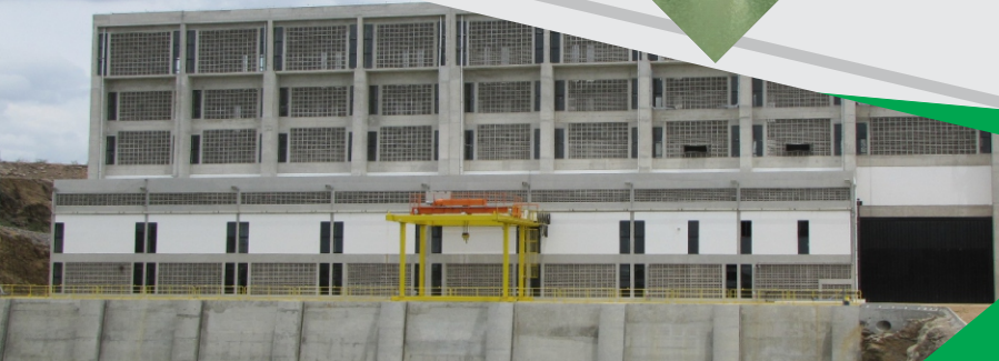
Estação de Bombeamento EBI-1
